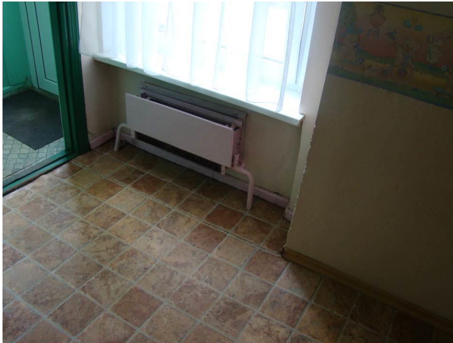
7.att. Apkuri ēkā nodrošina vecie radiatori. Tie ir novecojuši un ieteicams tos nomainīt
