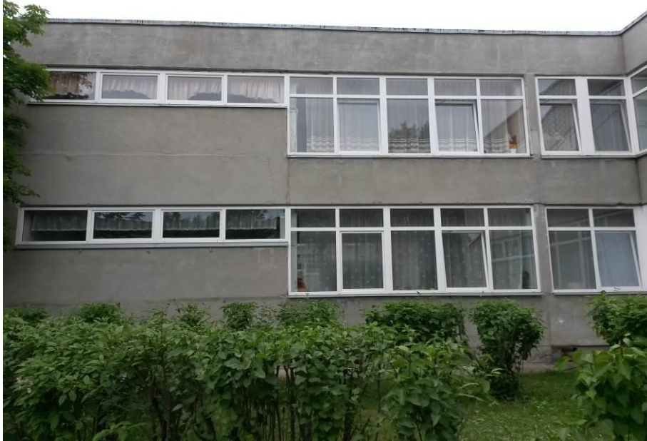
3.att. Ēkas fasādes ārsienas daļa. Visi ēkas logi ir nomainīti pret jauniem pakešu logiem PVC rāmjos. To stāvoklis vērtējams kā labs
